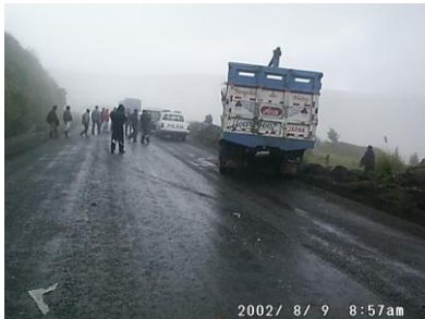
Calzada asfaltada mojada, presencia de neblina.
